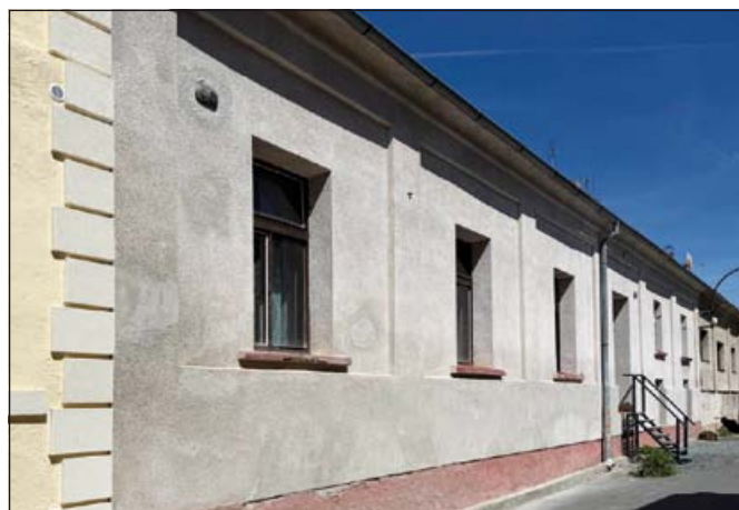
Částečně opravená fasáda na sokolovně; foto archiv města
