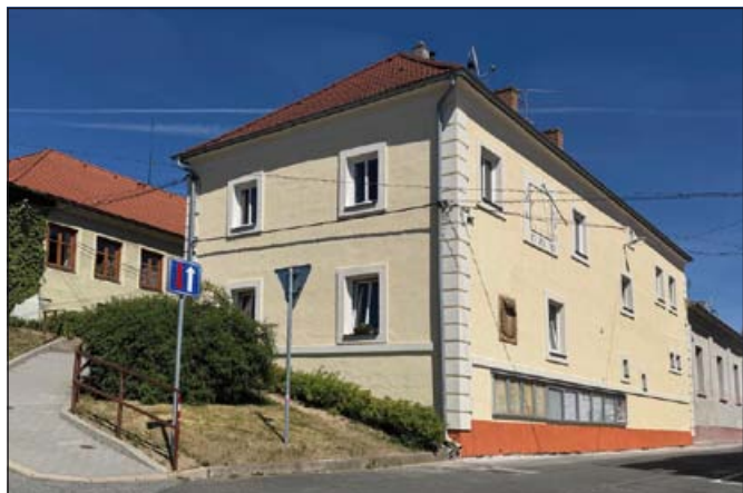
Opravená část fasády na domě čp. 26; foto archiv města
