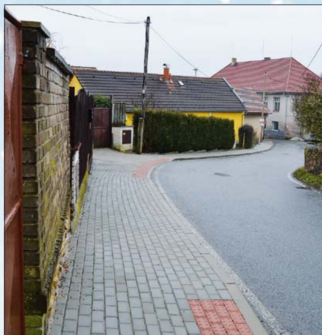
Dostavění části chodníku v ulici Dalkovická; foto archiv města
