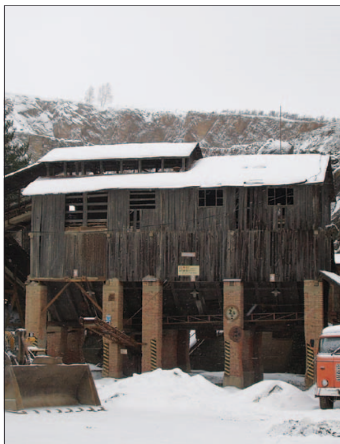
Budova drtiče z lomu v Bílkovicích. Stejný drtič se nacházel i v Trhovém Štěpánově. Fotografie se bohužel nedochovala.
