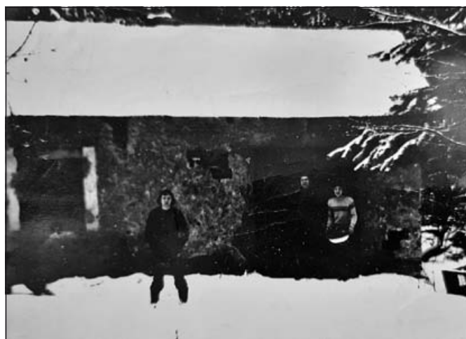
Bouda lomařů s garáží pro kompresor; foto Josef Korn 1976
