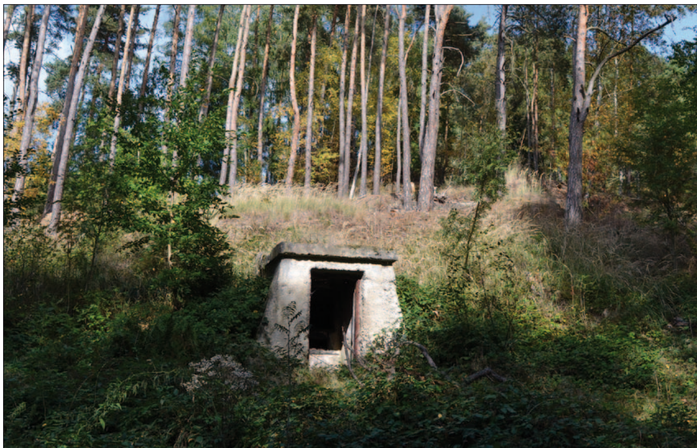
Bunkr na střelivo; foto Josef Korn
