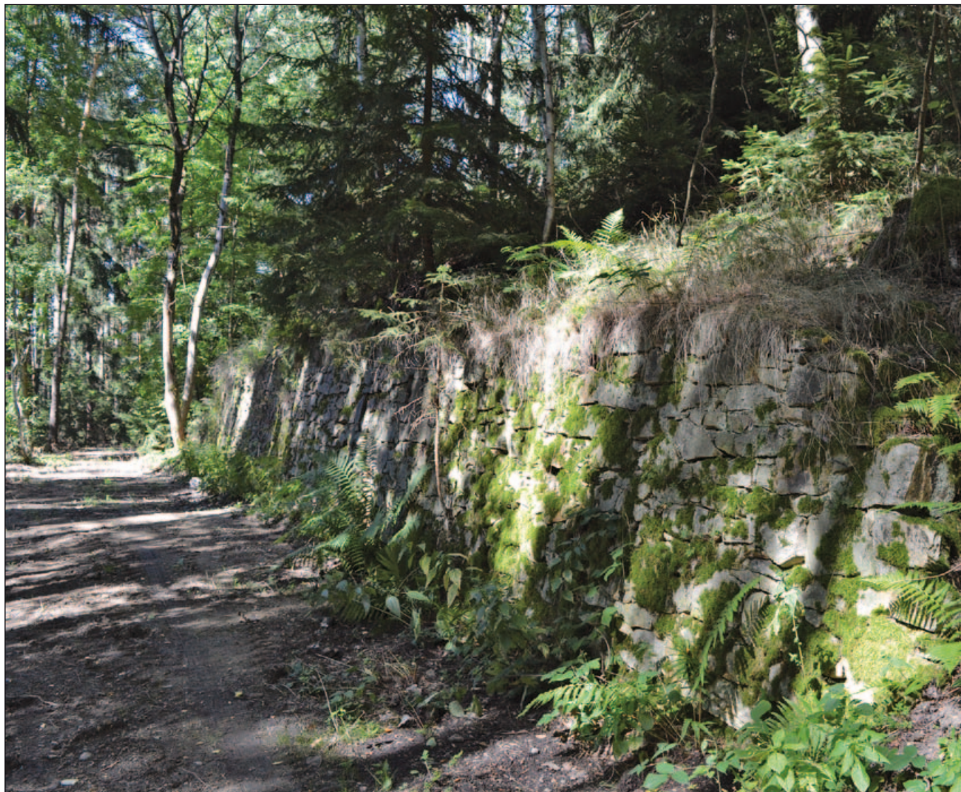
Opěrná zeď pod drtičem, zde padalo kamenivo šupnami na nákladní auta; foto Josef Korn
