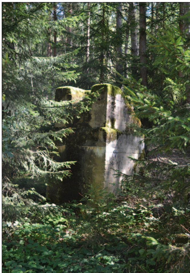
Fundament drtiče z 1. republiky; foto Josef Korn
