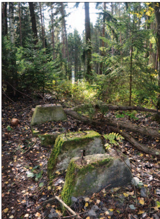
Základy pro stabilní dieselagregát Perkins; foto Josef Korn
