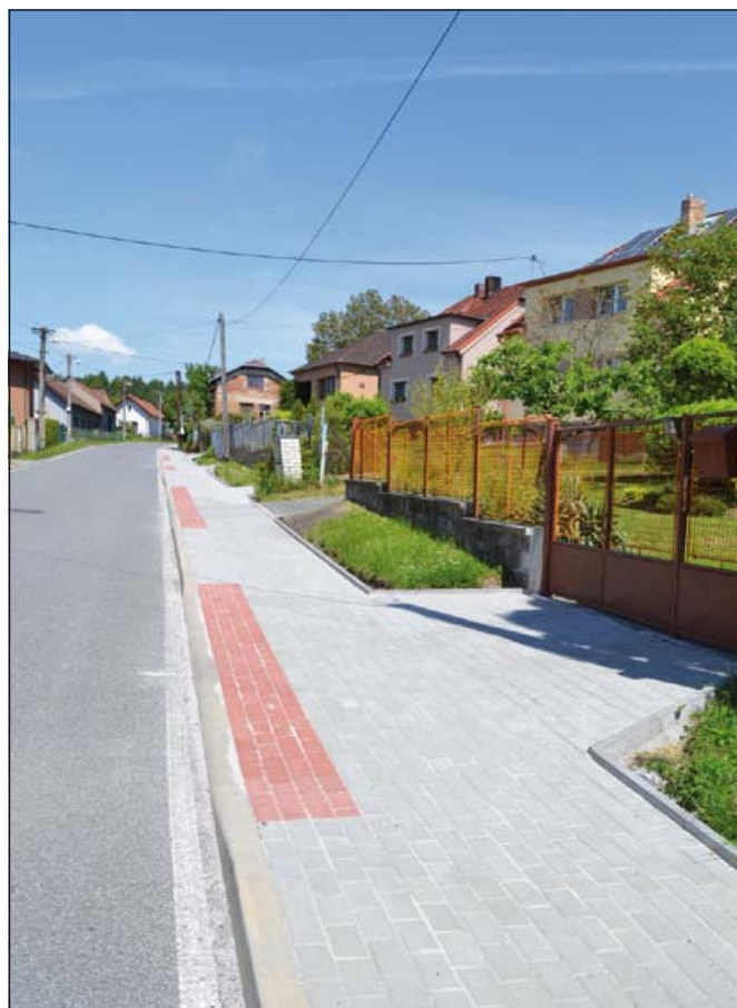
Nově položená část chodníku v ulici Dalkovická; foto archiv města
