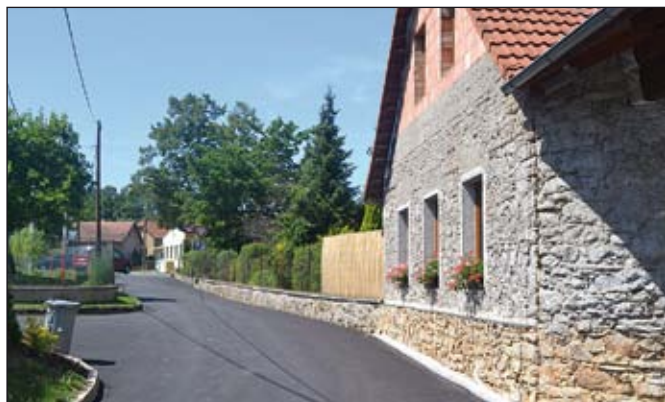
Oprava a asfaltace místní komunikace v Sedmpánech; foto Josef Korn
