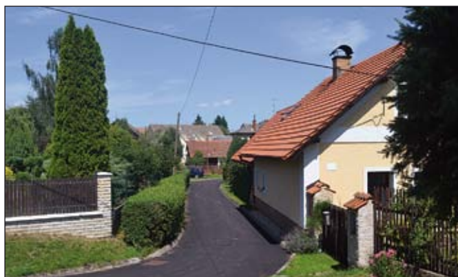
Dokončení opravy místní komunikace v Sedmpánech; foto Josef Korn
