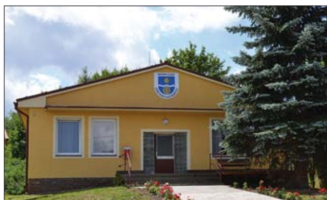
Oprava fasády a okapů na prodejně ve Střechově nad Sázavou
