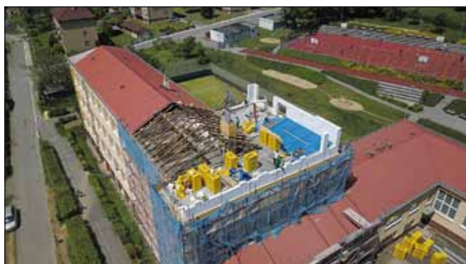
Začíná nadstavba III. nadzemního podlaží; foto Aleš Kamarýt
