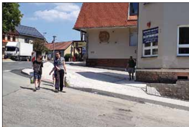
Zvýšení bezpečnosti dopravy ve městě Trhový Štěpánov – pokládka zámkové dlažby; foto Josef Korn
