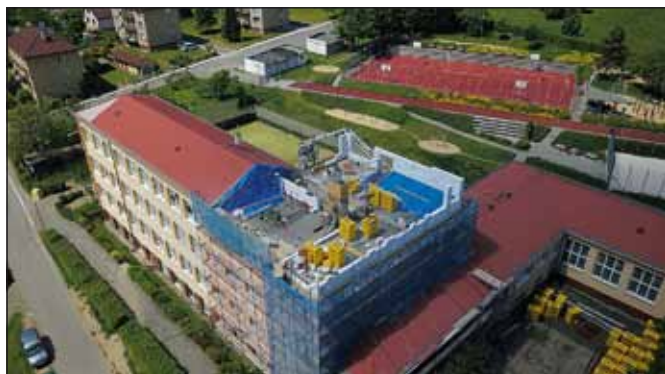
Odstraněn část krovu sedlové střechy; foto Aleš Kamarýt
