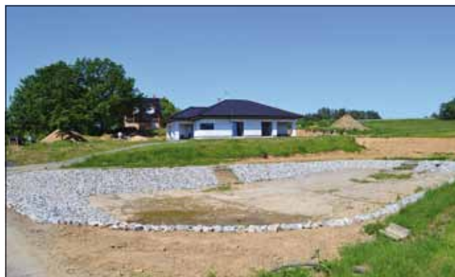
Zpevněné břehy vodní nádrže; foto Josef Korn
