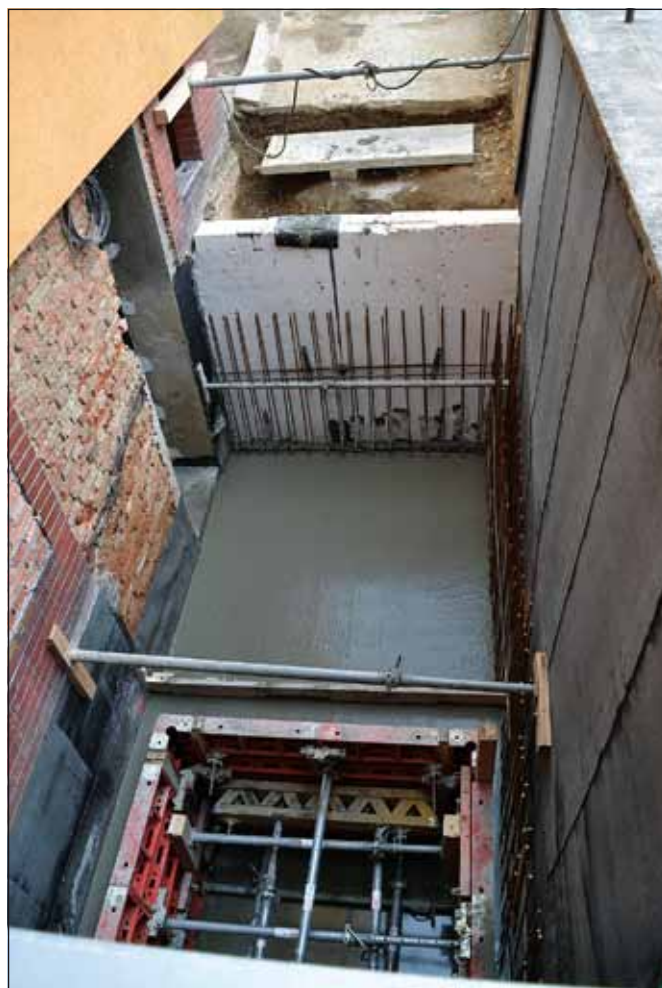
Betonáž výtahové šachty se vstupem do suterénu budovy; foto Josef Korn
