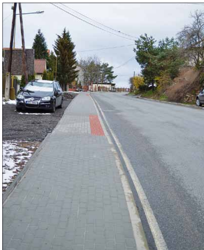
Dokončená část stavby chodníku v ulici Vlašimská; foto archiv města
