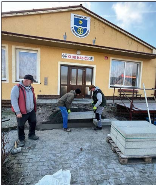
Oprava schodiště ve Střechově nad Sázavou; foto archiv města
