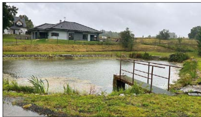
Preventivně upuštěná hladina rybníka v Dalkovicích; foto archiv města
