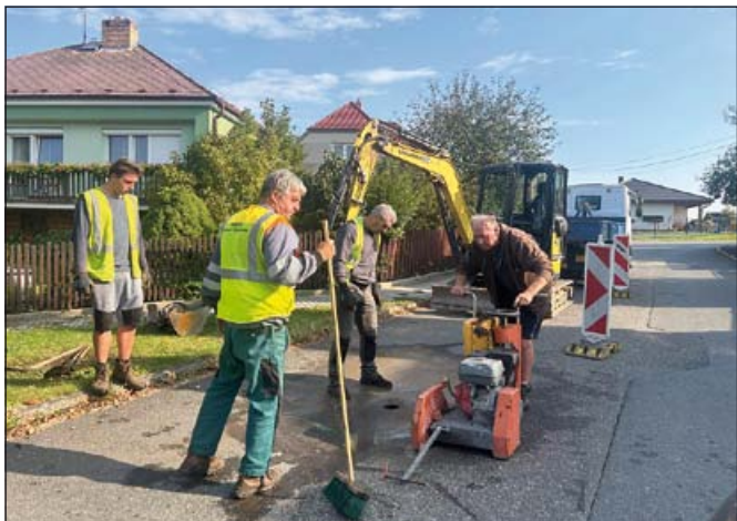
Oprava vozovky v ulici Polní; foto archiv města
