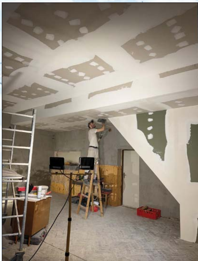
Nové stropní podhledy v celé budově KD Dalkovice; foto archiv města
