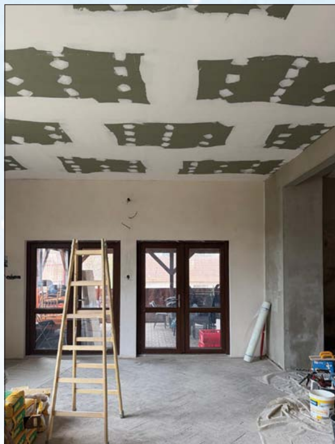
Práce na rekonstrukci KD Dalkovice jsou v plném proudu; foto archiv města
