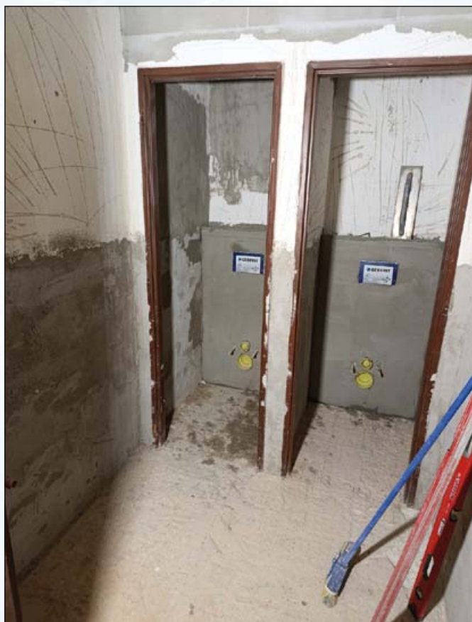
Rekonstrukce sociálního zázemí KD Dalkovice; foto archiv města
