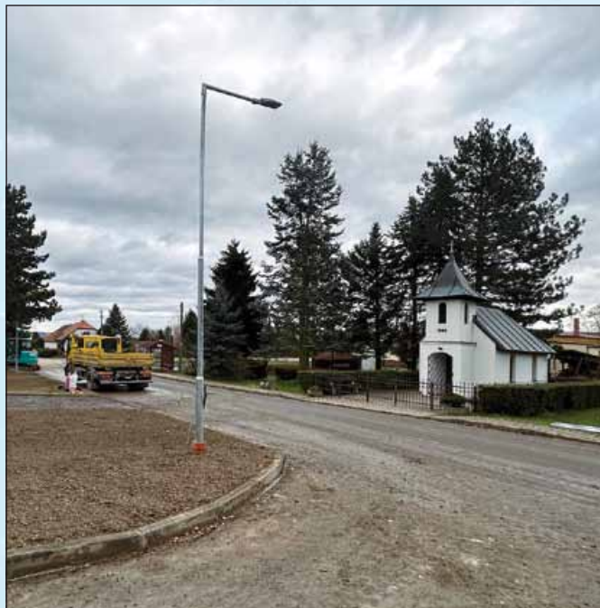
Nově nainstalované sloupy veřejného osvětlení; foto archiv města
