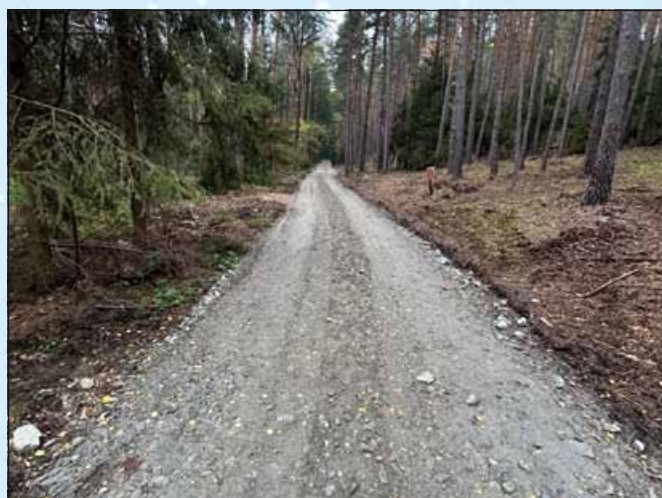
Opravená cesta k rozhledně od cyklostezky; foto archiv města
