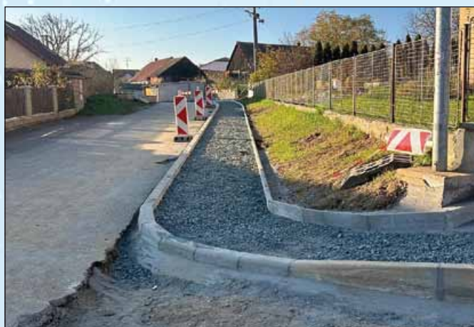
Práce na rekonstrukci chodníku; foto archiv města
