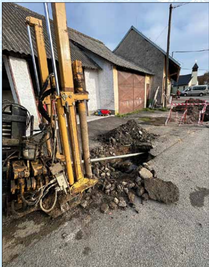
Podvrtání komunikace pro budoucí nové vedení vodovodu; foto archiv města
