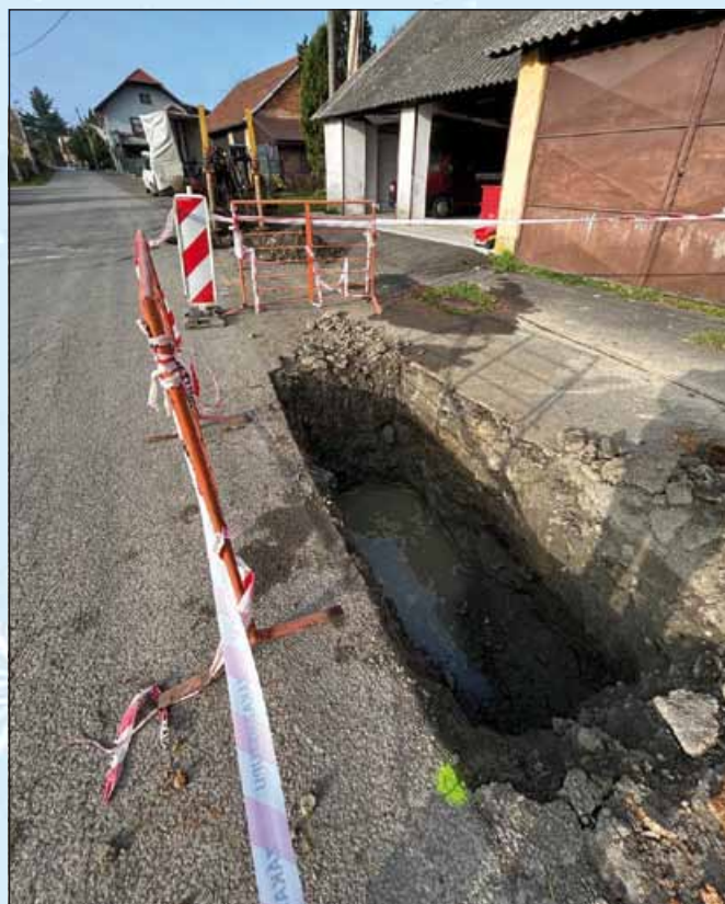
Startovací jáma pro podvrtový stroj; foto archiv města
