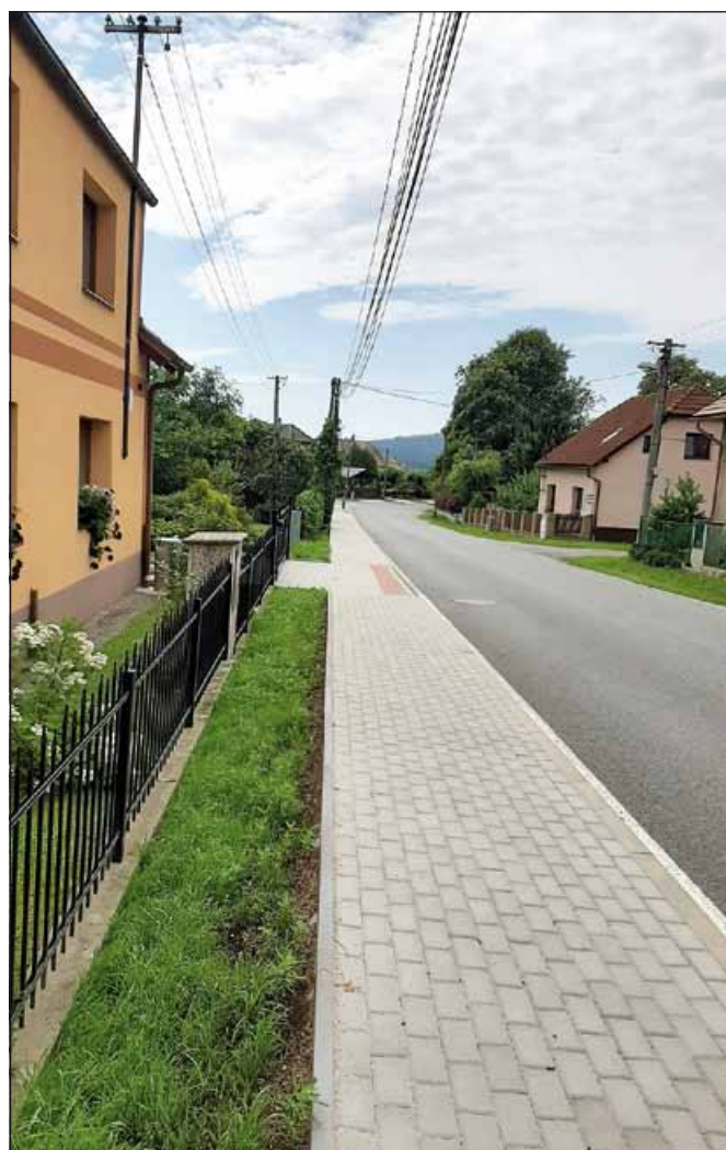
Dokončení stavby části chodníku v ulici Dalkovická; foto archiv města
