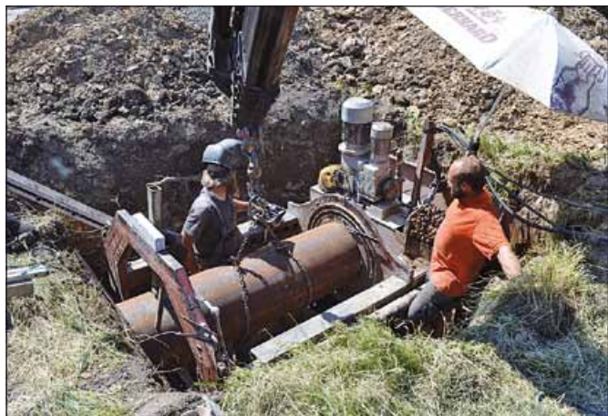
Protlak ocelového potrubí průměr 500 mm, délka 15 m; foto archiv města
