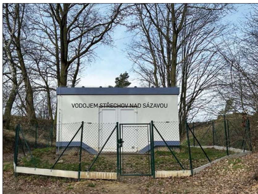
Vodojem Střechov nad Sázavou; foto archiv města
