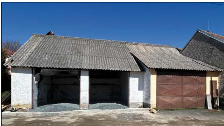
Rekonstrukce hasičské zbrojnice v Dalkovicích; foto archiv města
