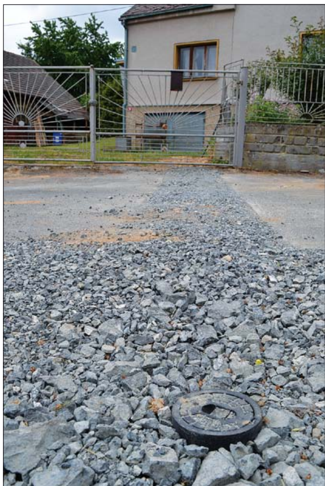
Dokončená vodovodní přípojka k nemovitosti; foto archiv města
