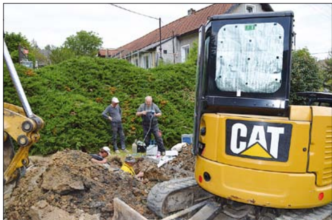
Stavební ruch ve Střechově; foto archiv města
