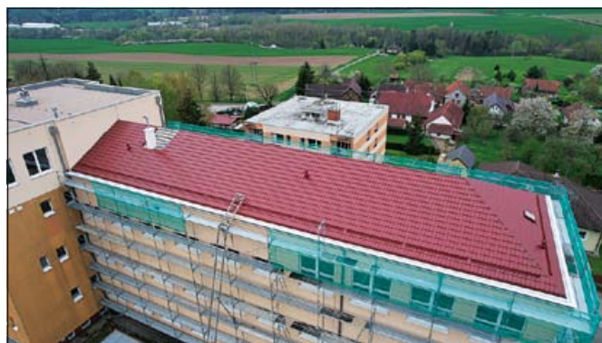
Nová krytina na hlavní budově; foto archiv města
